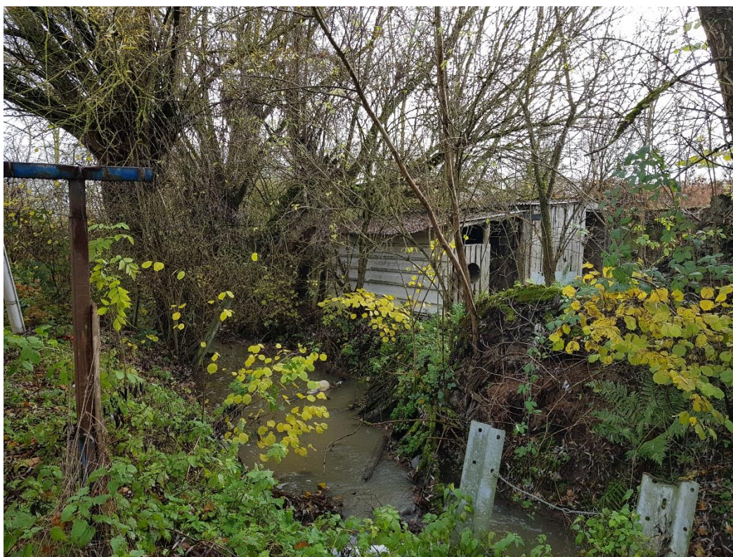
Figure 2: La Verse à la Faisanderie vue vers l'amont
